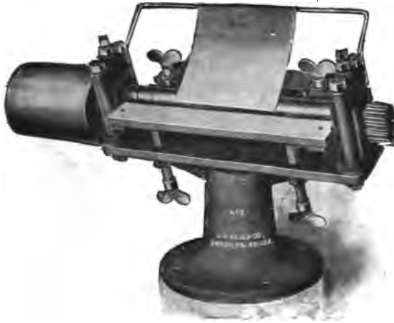
Appareil Bliss pour cintrer les corps de boîtes.
